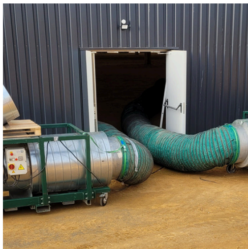
Ventilation extraction (travaux de décaissement)
