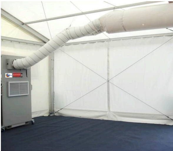
Climatisation avec gaines de diffusion
