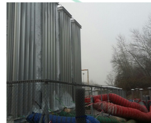
Dégivrage échangeur atmosphérique
