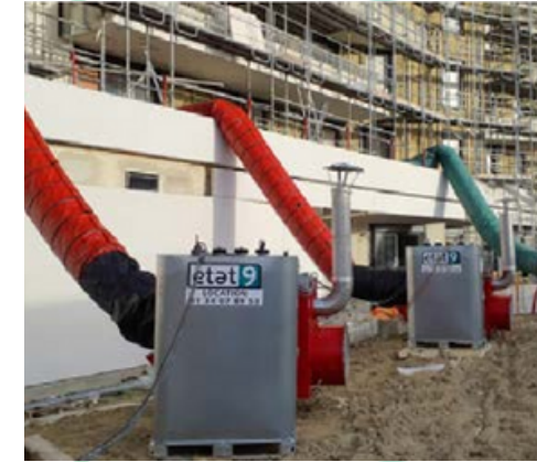
Chauffage bâtiment en rénovation
