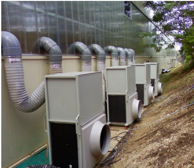
Climatisation réversible en mode chauffage
