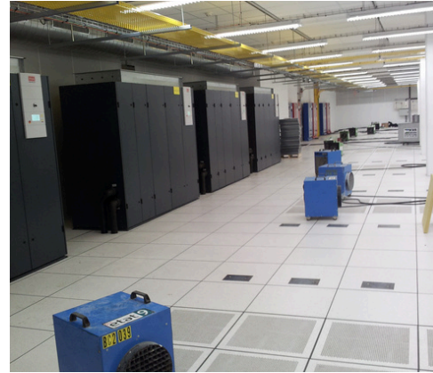
Simulation banc de test puissance électrique
