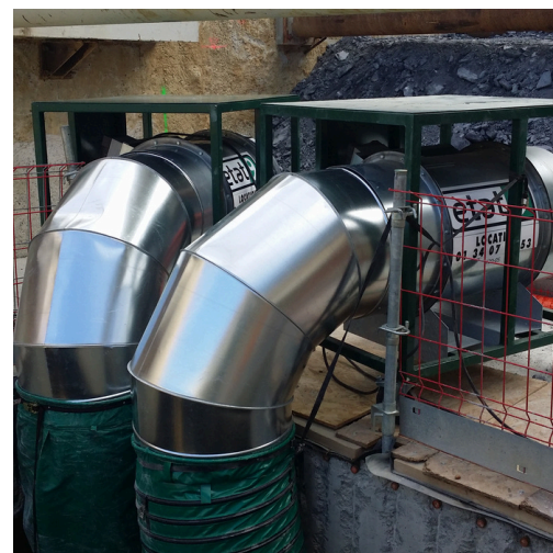
Aspiration et insufflation d'air neuf dans volume confiné
