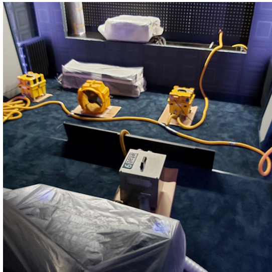
Assèchement des matériaux/mobiliers après sinistre dégâts des eaux
