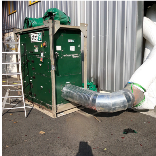
Séchage et mise sous stop corrosion après sinistre
