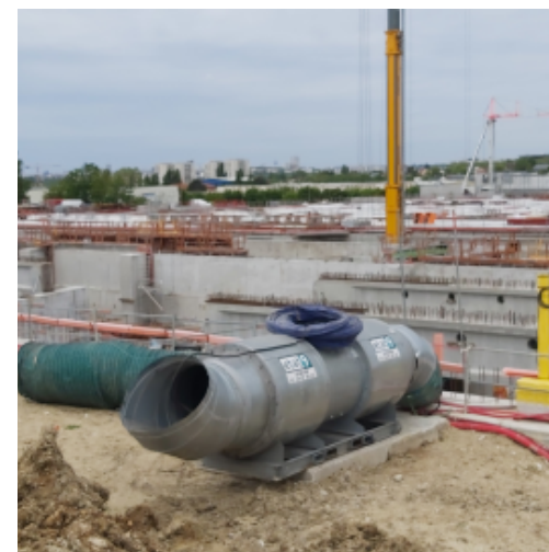
Amenée d'air neuf (travaux de bâtiment en infrastructure)
