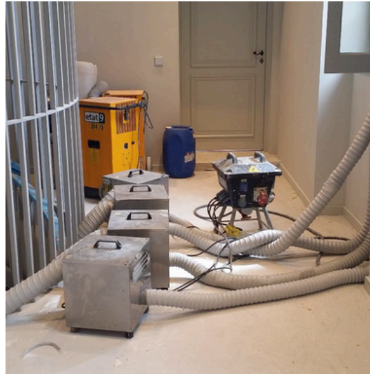
Séchage accéléré des matériaux pour pose des revêtements
