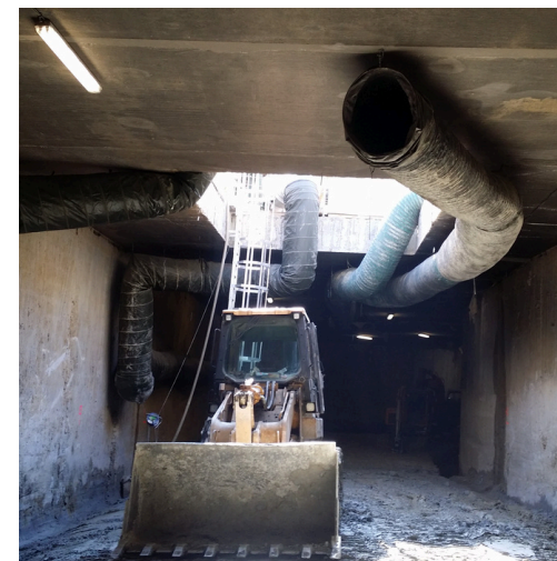
Réseaux aérauliques d'extraction de polluant
