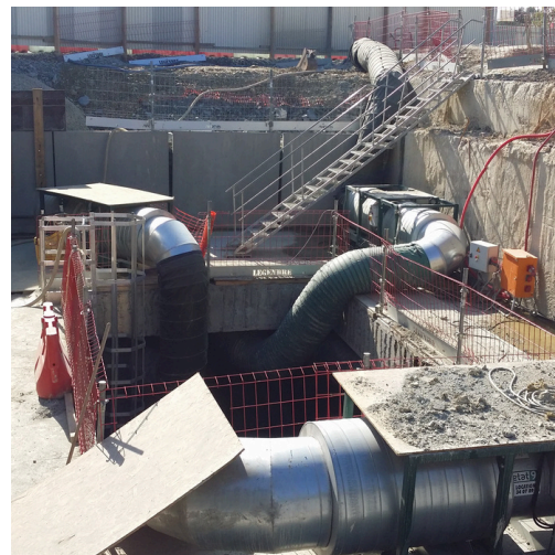
Extraction et amenée d'air neuf travaux en tunnelier
