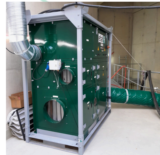
Assèchement des supports et du volume (application de résine)
